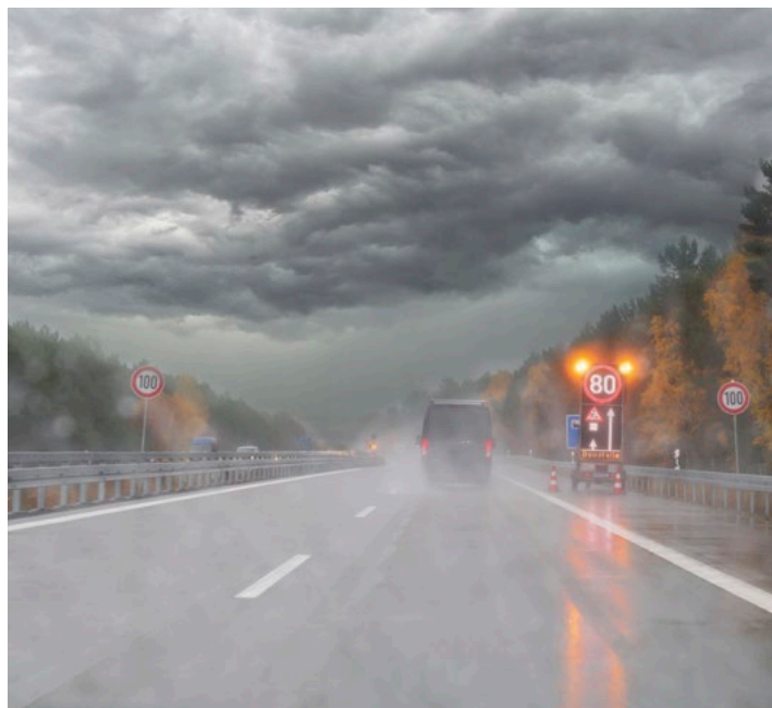
Las condiciones meteorológicas adversas suponen un elevado riesgo de accidentes, también en las zonas de obras.
