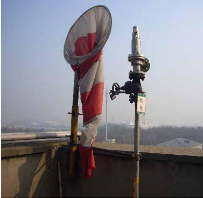
Válvula de alivio con soporte insuficiente y válvula manual
