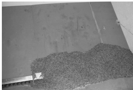
Fig. 5.4 Interior d'una sitja d'obra on s'aprecien les rampes a 45° d'inclinació i el vis sens fi que extreu el pèl·let i el condueix a l'alimentació de la caldera.
