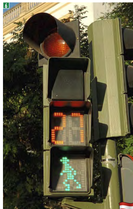
Semáforo para peões com sinal amarelo para “liberação”
