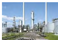
Verificação de material e inspeção
