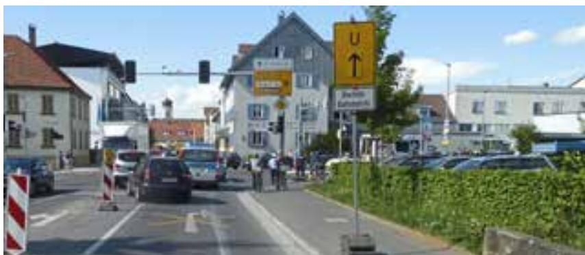
■ Antes das obras rodoviárias, a situação de tráfego revelava-se muito complexa neste local, em particular para ciclistas.
