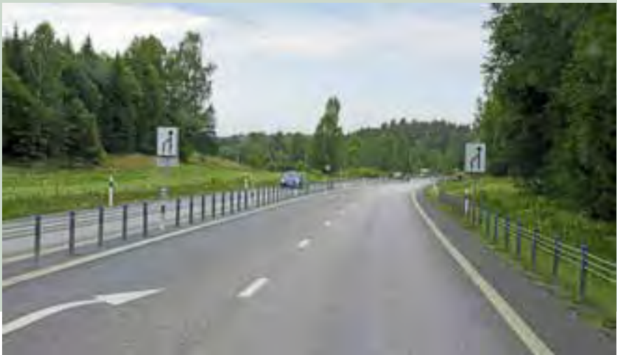
As estradas 2+1 já deram provas do seu valor em numerosos países do mundo. No entanto, para os motociclistas, as barreiras entre as faixas de rodagem podem representar um risco elevado de ferimentos em caso de colisão.
