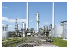
Contrôle des matériaux et inspection
