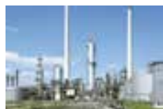
Contrôle des matériaux et inspection
