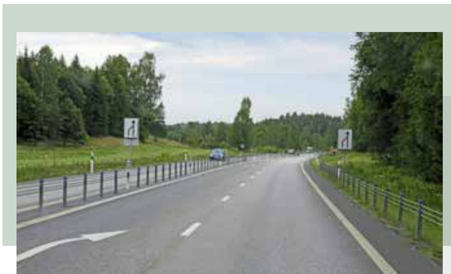
Les chaussées en 2+1 ont fait leurs preuves dans de nombreux pays du monde. Les barrières qui séparent les sens de circulation peuvent cependant représenter un risque élevé de blessure en cas de collision.
