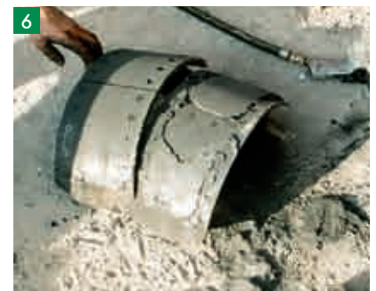
6 Aufgrund der Überhitzung zerfallener Bremsbelag
