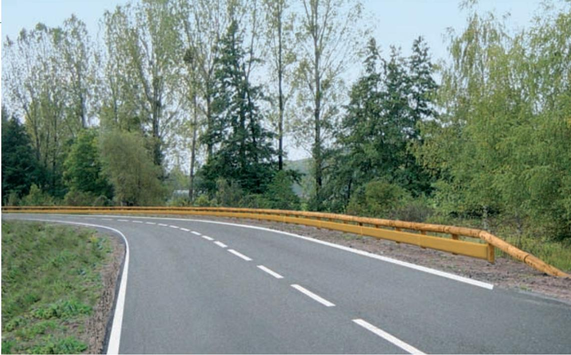
*In das Landschaftsbild integrierte Sicherheit: NATUR-Rail mit Unterfahrerschutz wurde speziell für die Ausstattung von kurvenreichen Motorradstrecken konzipiert. Durch den nachgiebigen Unterfahrerschutz wird das Rutschen unter die Schutzplanke verhindert.*
