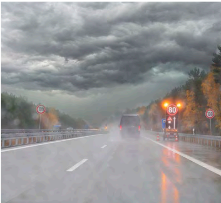
Ungünstige Witterungsverhältnisse werden gerade auch in Baustellenbereichen zu einem hohen Unfallrisiko.
