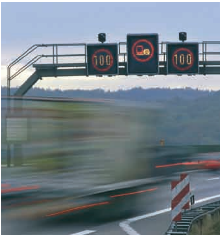
I dispositivi per la regolazione del traffico possono contribuire a ridurre il rischio di incidenti.
