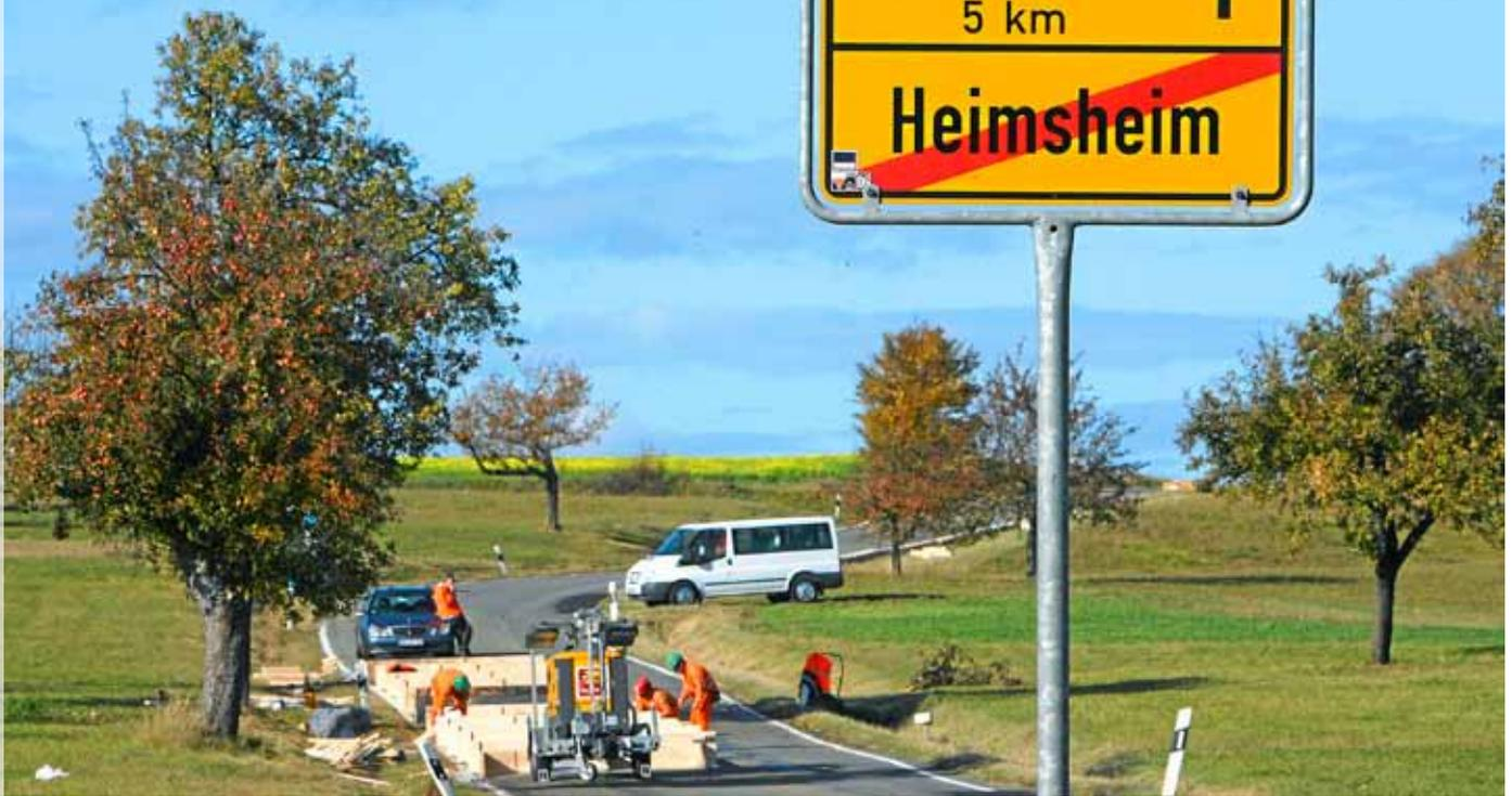
À l'automne 2011, Daimler AG a fait copier sur certains secteurs la couche de roulement d'une chaussée située dans la région de Stuttgart, entre Friolzheim et Heimsheim. Il s'agit d'une route en très mauvais état et les quatre moulages réalisés ensuite dans une usine de béton préfabriqué en reprennent le moindre détail – nids de poule, défauts d'uni, ondulations, fissures de l'asphalte. Ces moulages servent désormais à reproduire la chaussée pour les pistes d'essai de Daimler.
