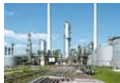
Contrôle de matériaux et inspection
