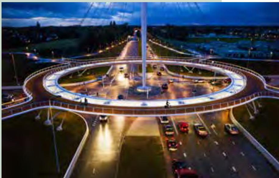
Aufgehängt mit 24 Abspannseilen an einem 70-Meter-Pylon erspart der „Hovenring“ zwischen den niederländischen Städten Eindhoven und Veldhoven täglich etwa 5.000 Radfahrenden die Überquerung einer vielbefahrenen Straßenkreuzung.
