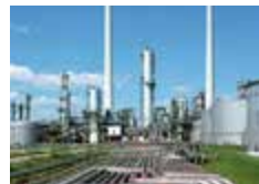
Pruebas de material & inspecciones
