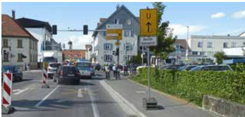
■ Delante de las medidas de construcción, la situación del tráfico en este punto era muy confusa, especialmente, para los ciclistas.
